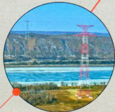
ЛЭП 500 КВТ В КНР
