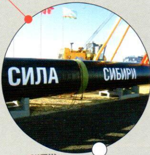
ГАЗОПРОВОД «СИЛА СИБИРИ»
